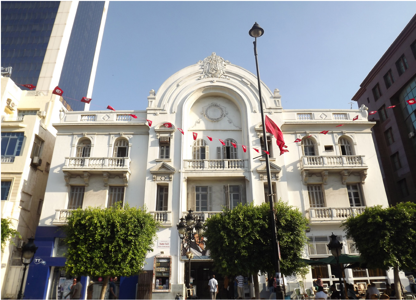
4. Façade principale du cinéma Le Palace, construit en 1903 sur l'artère principale de la capitale tunisienne. © wikimédia.
