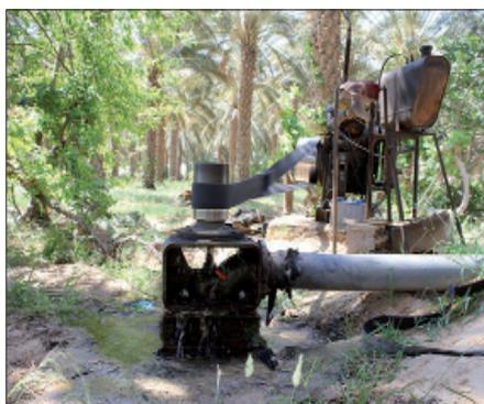
Forage privé : au premier plan la partie visible du forage constitué par la pompe qui est actionnée par le moteur au second plan, El Massaid (gouvernorat de Kebili) © Emna KHEMIRI.
